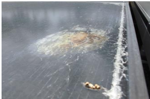
写真 6-18 26 直撃雷による破損
