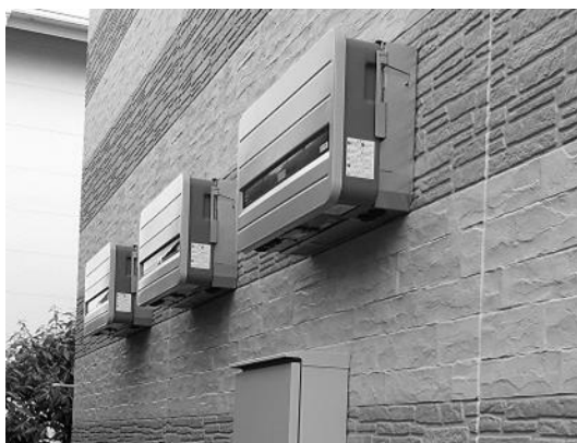
図 4-4 パワーコンディショナの取付
