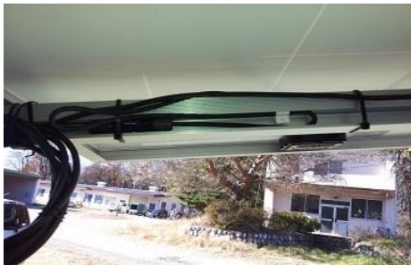
写真 6-11 コネクタ勘合部の固定
