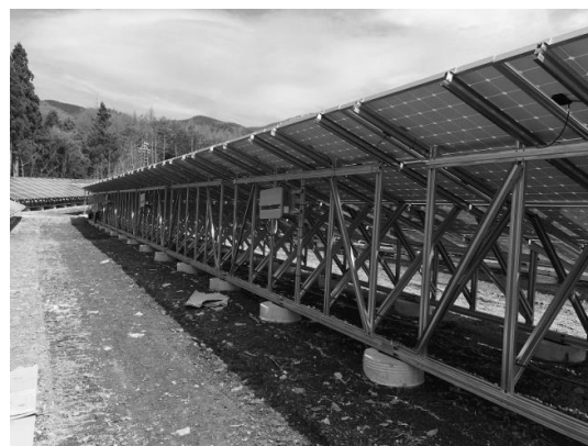
図 4-4 パワーコンディショナの取付
