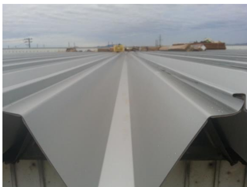
図 3-4 折板屋根・金属縦葺き屋根
